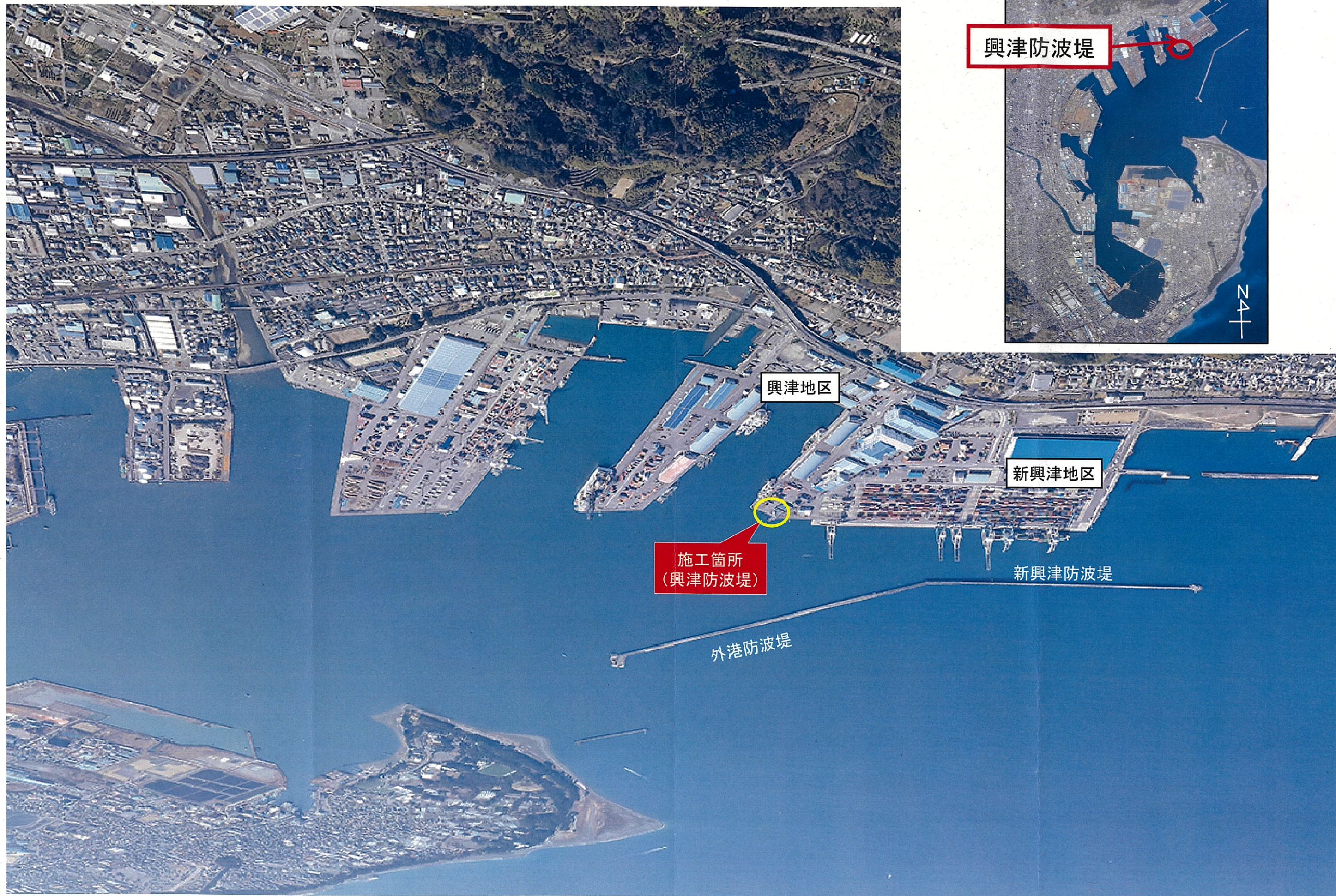
施工位置(清水港全体写真)
